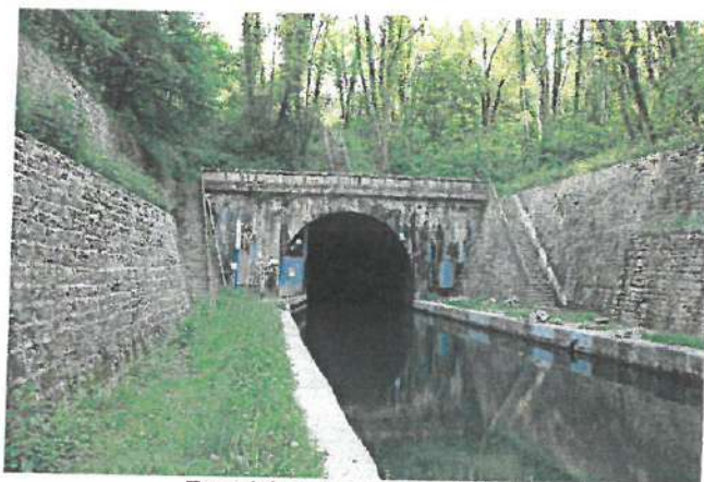
Tunnel de Balesmes, entrée Sud
