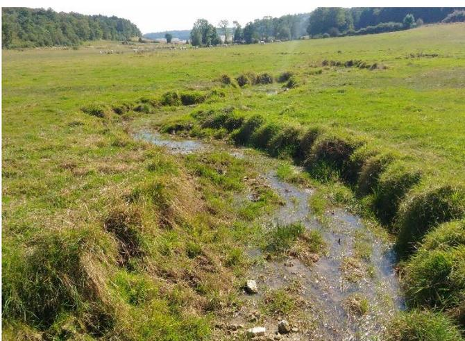
La Pisancelle à Poissons après travaux (avant travaux, le lit était rectiligne et enfoncé de plus de 2 m)
